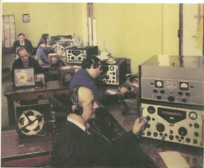
Estación radiomarítima de Alcobendas en la década de 1970.
