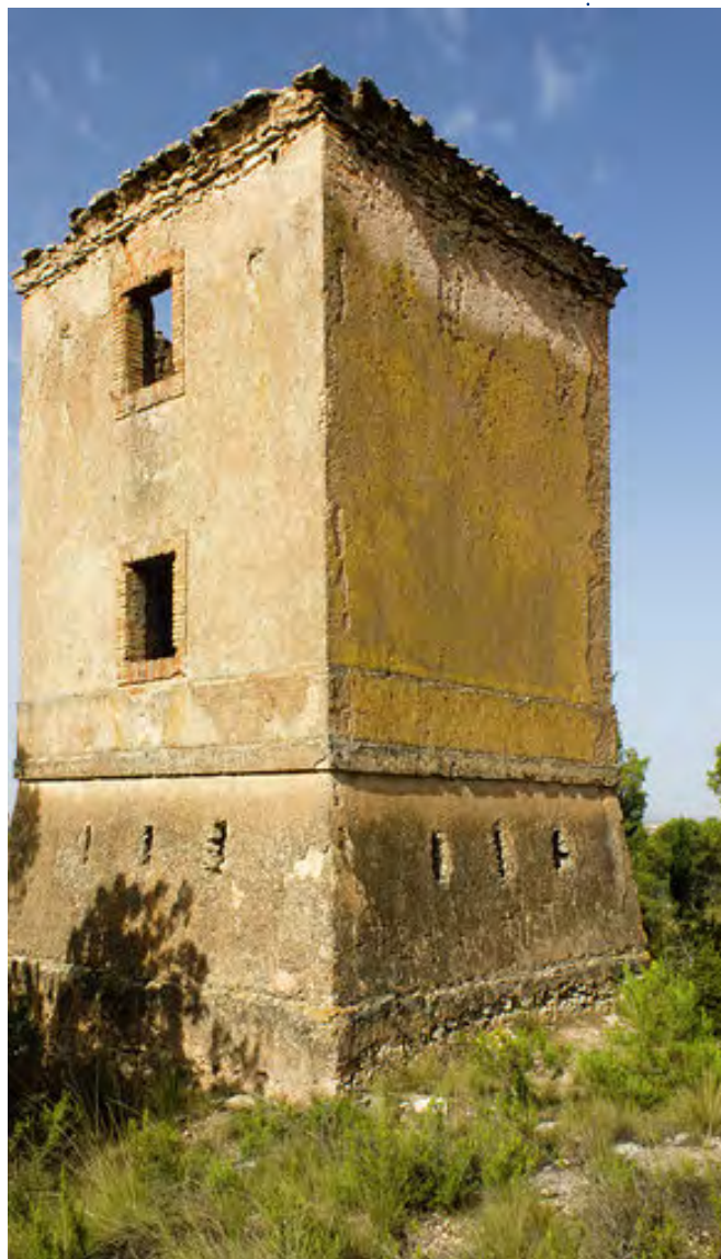
Torre Atalayón, Línea Principal
