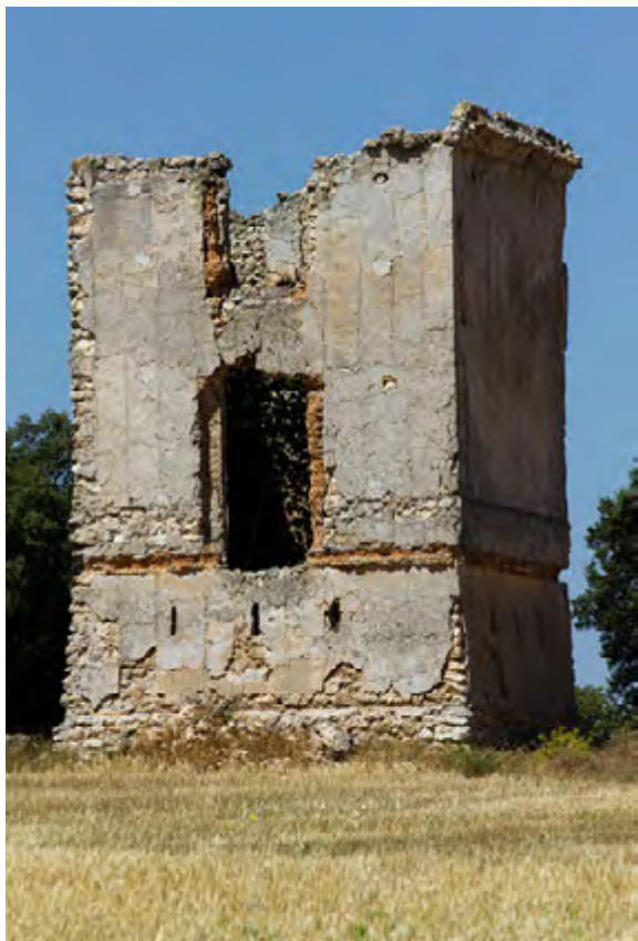
Torre Horcajada, Ramal de Cuenca
