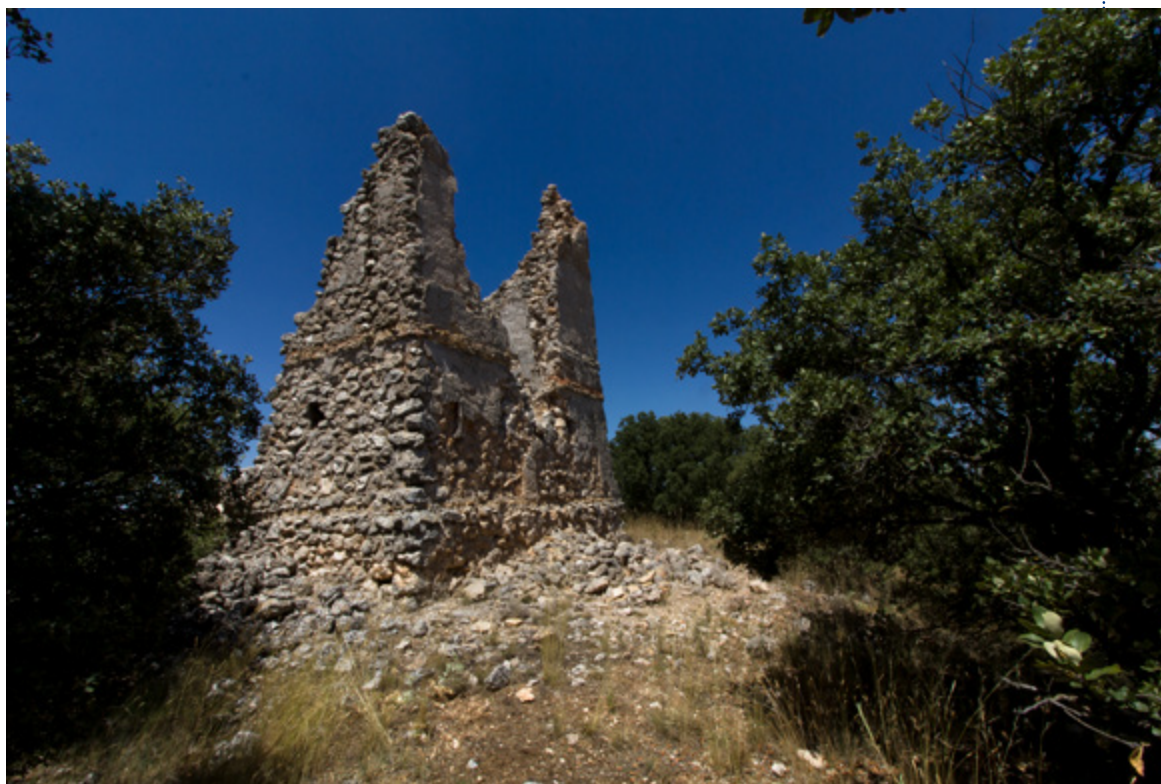
Torre óptica Torrejoncillo
