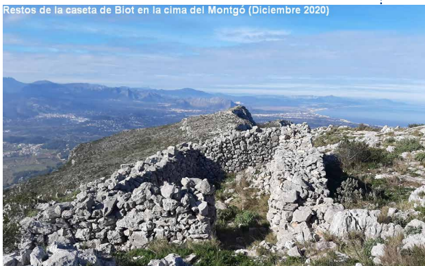
Restos de la caseta de Biot en la cima del Montgó (Diciembre 2020)
