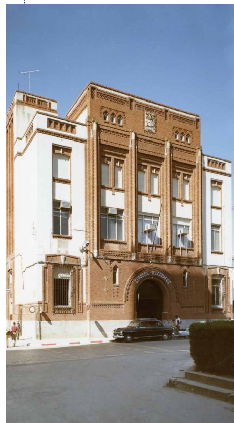
Edificio de Correos y Telégrafos de Badajoz
