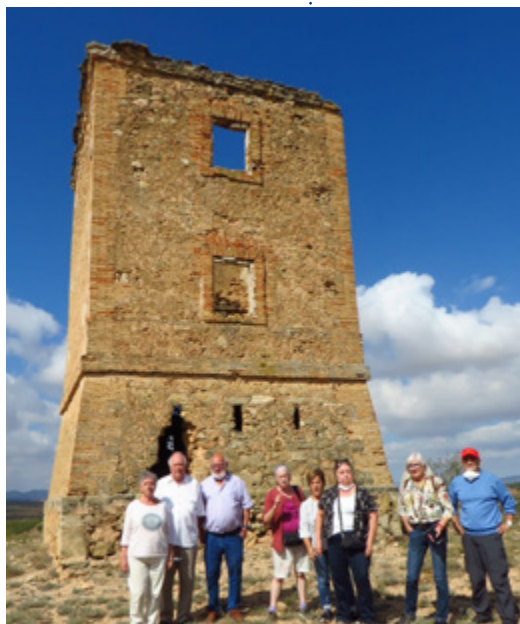
Torre óptica nº 23. Línea Madrid-Valencia-Barcelona
