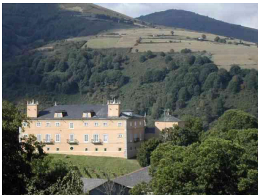
Figura 41. Palacio de Doncos rehabilitado. Década de 1990
