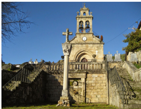
Figura 6. Escaleras de acceso a la Iglesia de Santa María. Pungín
