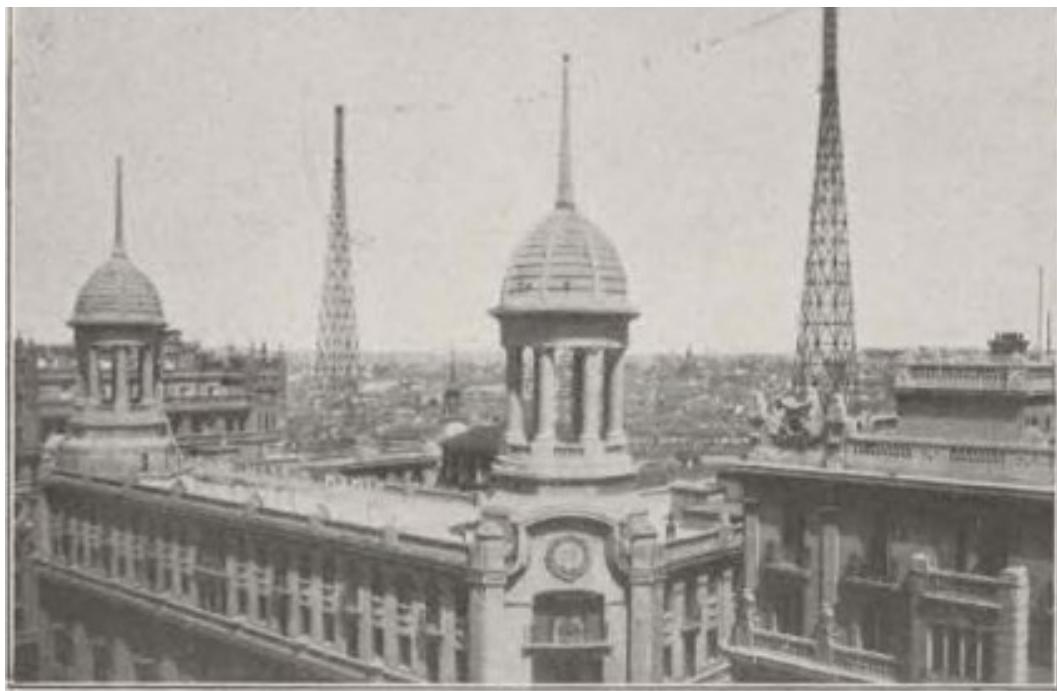
Mástiles y antenas de la emisora Unión Radio Madrid
