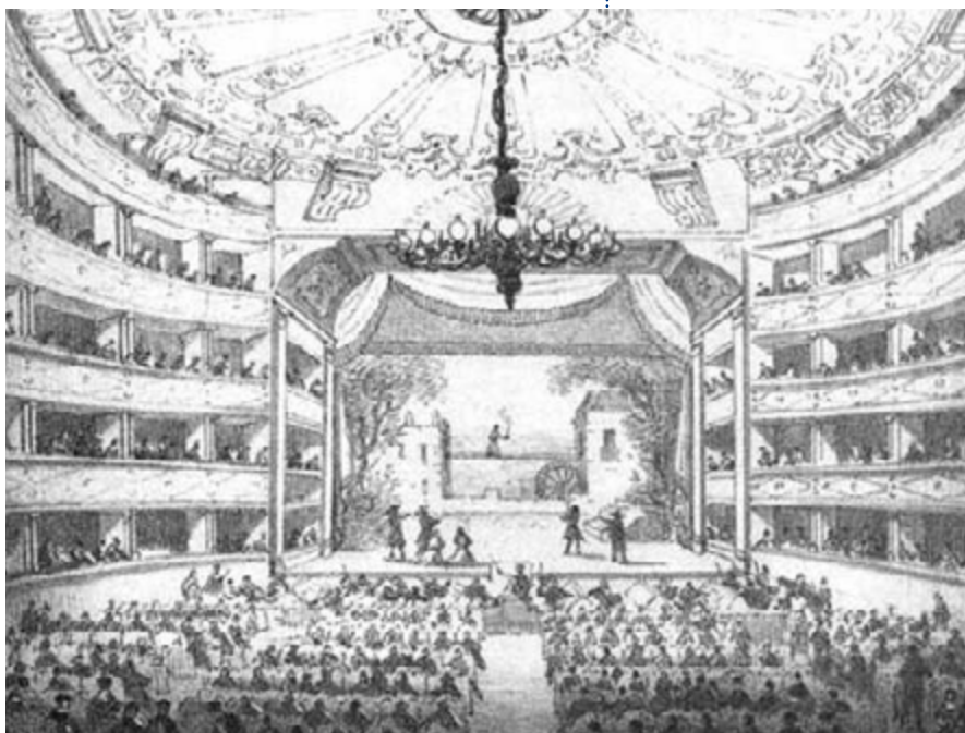
El desaparecido Teatro Principal de Cádiz, en el que Bonnet instaló el primer alumbrado eléctrico permanente.
