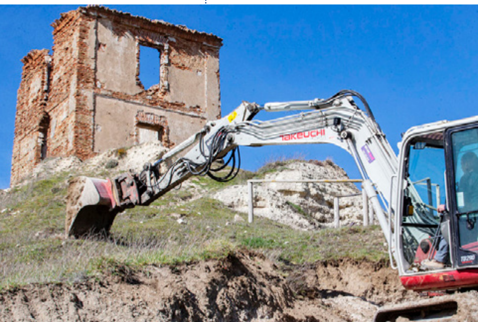
Obras para acceso a la Torre Óptica
