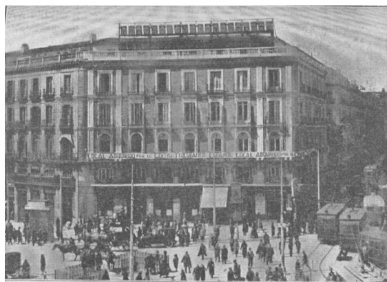
Foto 5. Fachada principal del Centro Telegráfico Español
