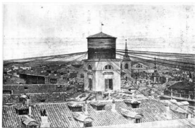
Foto 11. Torre de concentración de hilos telefónicos de la Central Telefónica de la plaza de Pontejos de Madrid.1917.
