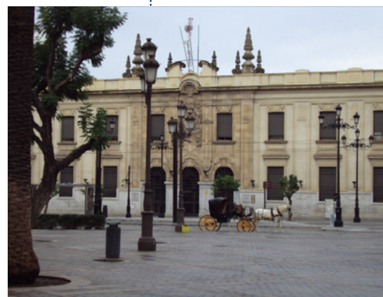
Edificio de Correos y Telégrafos de Sevilla
