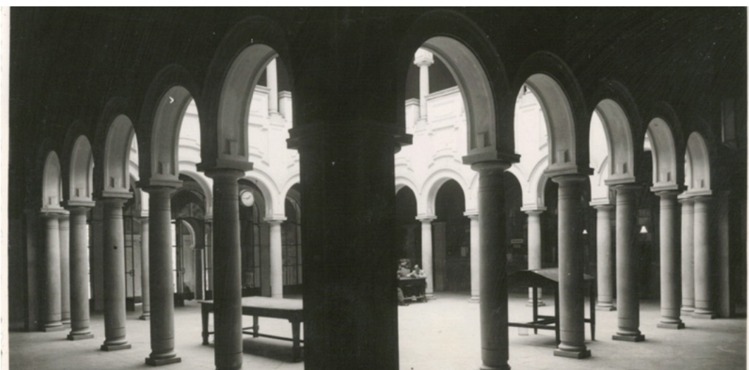
Patio interior del edificio de Correos y Telégrafos de Sevilla
