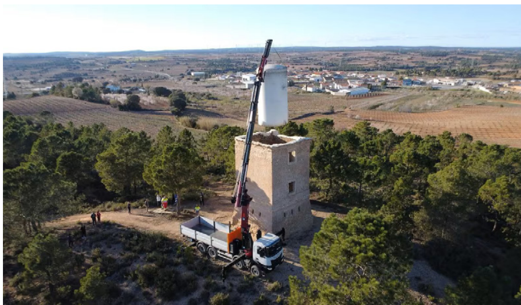
Inicio de las obras de restauración de la torre de telegrafía óptica número 20, "La Mochuela" Graja de Iniesta (Cuenca).
