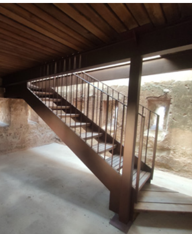
El piso inferior de la torre, una vez restaurado. Foto: Jesús López.
